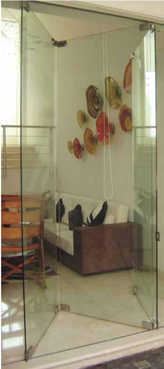
El sistema plegable con herrajes es un cancel que proporciona transparencia y elegancia, de fácil instalación y fácil de ajustar una vez instalado, garantizando una larga vida y funcionamiento.
